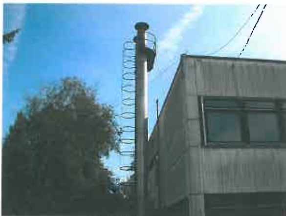
Kazánház kéménye az északkeleti homlokzat előtt
