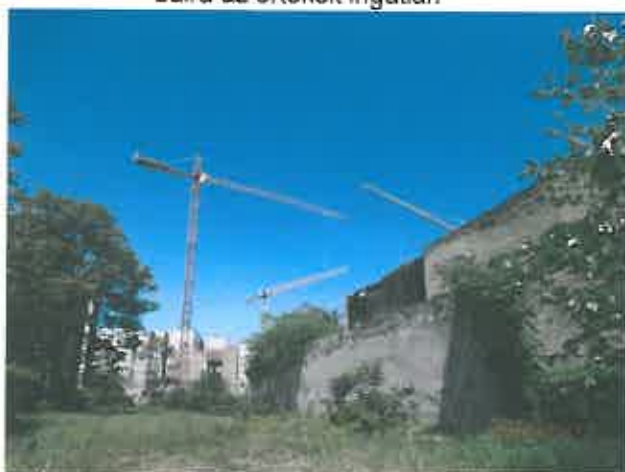
Értékelt ingatlan épületének tűzfala a szomszédos telek felől, mögötte építkezés
